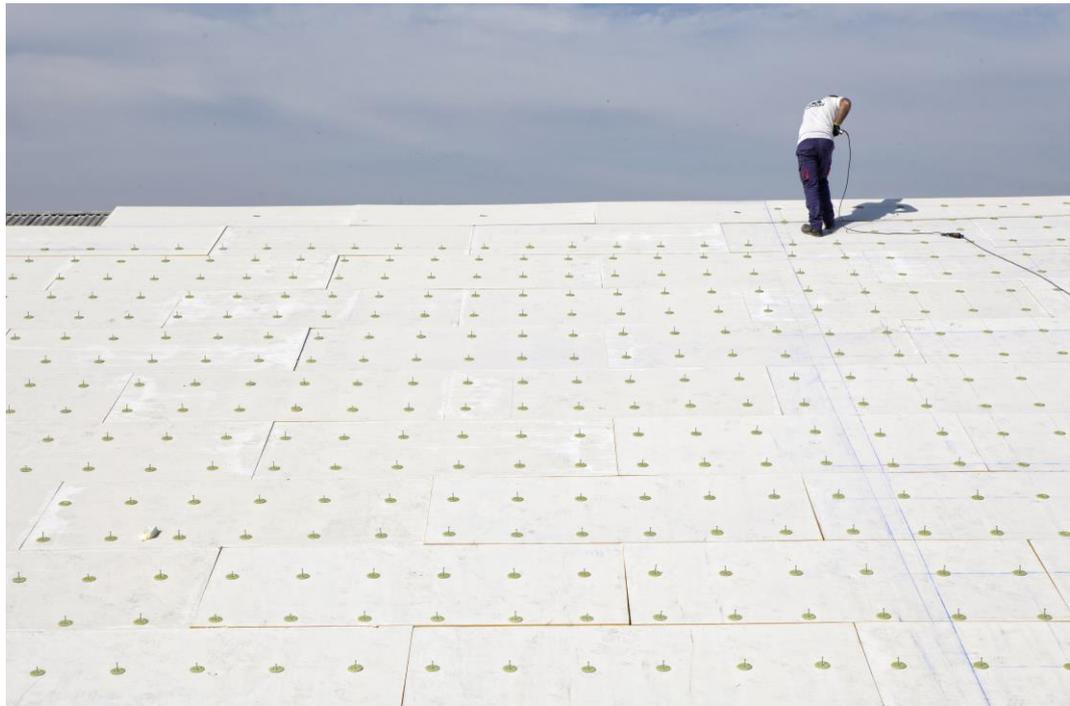
Sikatherm Pir es un aislante de muy baja conductividad térmica (0,024 W), inferior a la de otros aislantes tradicionales, lo que permite utilizar menores espesores y reducir así el peso que se añade a la estructura. No se derrite al fuego, ni propaga las llamas e incorpora una doble capa de velo de fibra que le hace compatible con láminas de PVC y FPO.
