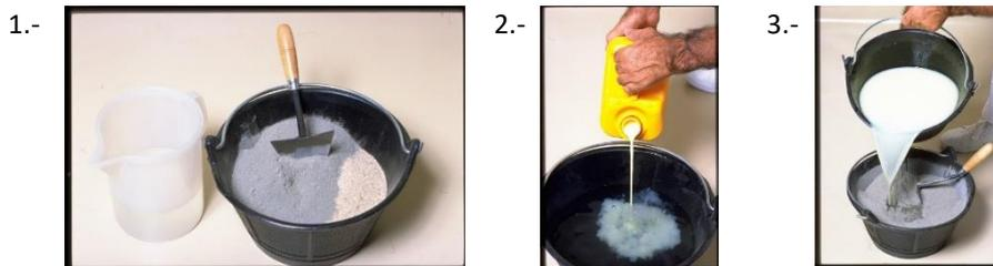
Mezclar el cemento y arena con la solución de **SikaLatex®** y agua hasta llegar a una consistencia aplicable con brocha.
