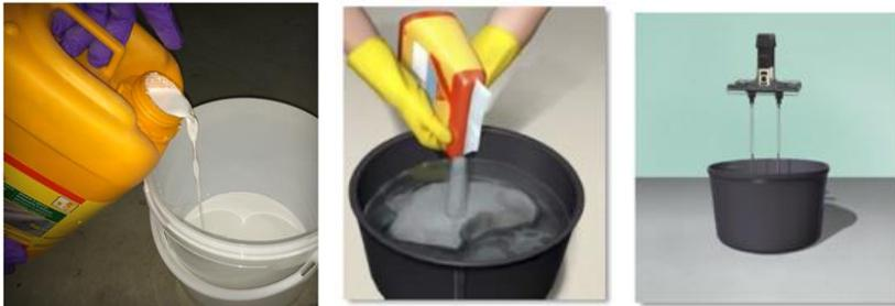
Homogeneizar el componente A (líquido) antes de su uso. Verter aproximadamente la mitad del componente A en el recipiente de mezclado y añadir la parte B (polvo) lentamente mientras se mezcla. Añadir la parte restante del componente A y continuar mezclando hasta que se consiga una consistencia uniforme y sin grumos.
