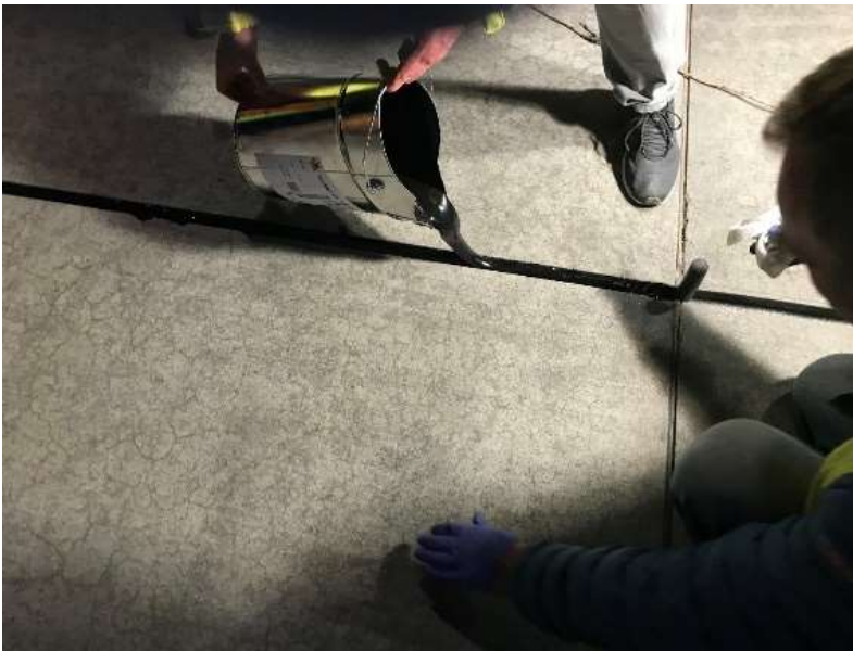
Imagen 3: aplicación del Sikaflex 406 KC directamente desde el cubo
