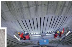
Una vez analizadas las fotografías, mediciones y la evolución de las patologías, se concluyó que los problemas de fisuramiento vertical parecían tener su origen en que las armaduras no eran capaces de absorber los esfuerzos a los que estaba sometida la estructura, principalmente por la acción del viento; aunado al progresivo deterioro del hormigón por envejecimiento.
