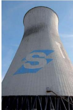
La Central Térmica de Puertollano, ubicada en la carretera de Puertollano a Mestanza, posee una potencia instalada de 220 MW, producida por un grupo monobloque que entró en servicio en abril de 1972. El sistema de refrigeración de agua de circulación se lleva a cabo a través de una torre de refrigeración de tiro natural.
