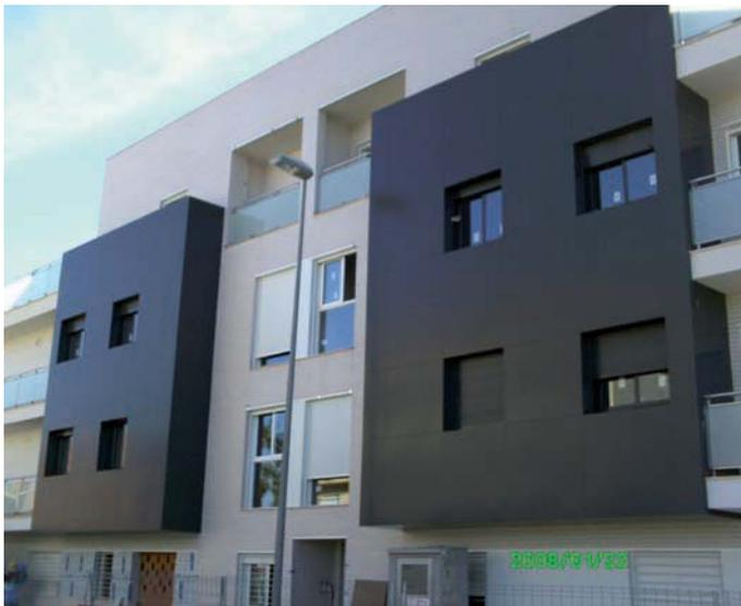
Comcubais llevó a cabo el pegado elástico de paneles de composite de aluminio en un fachada mediante el Sistema SikaTack® Panel, procedimiento que proporciona una gran seguridad y presenta una gran calidad en el pegado de este tipo de paneles, planchas Larson Composite.
