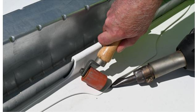
Soldadura por aire caliente de SolaRoof® Click a la membrana
