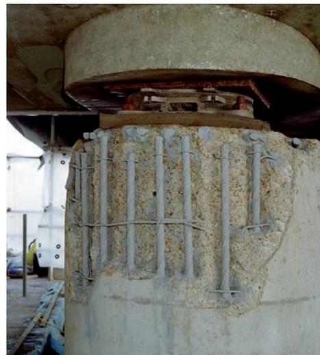
**Método 11.2** Pintado de la armadura con revestimiento barrera
