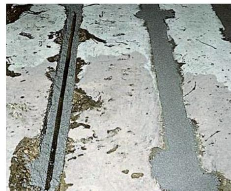
**Método 4.2** Instalación de barras de unión en agujeros prefabricados u horadados en el hormigón
