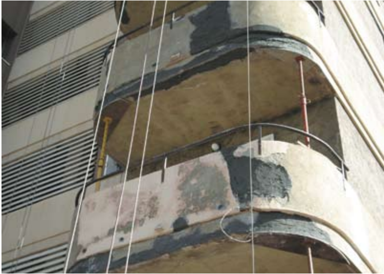
El edificio antes y después del proceso de rehabilitación de su fachada, muy debilitada debido al proceso de carbonatación del hormigón que hace aparecer fisuras en forjados
