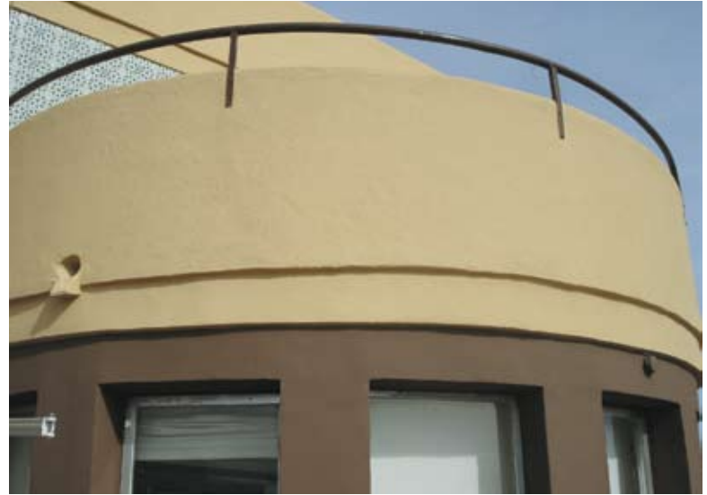
El edificio antes y después del proceso de rehabilitación de su fachada, muy debilitada debido al proceso de carbonatación del hormigón que hace aparecer fisuras en forjados
