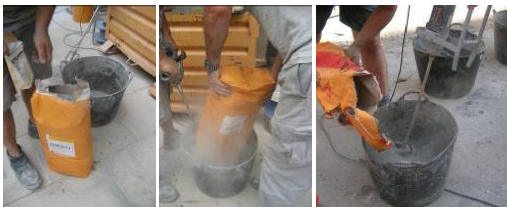
Mezclado con batidora de bajas revoluciones
