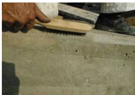
Preparación soporte: cepillado
