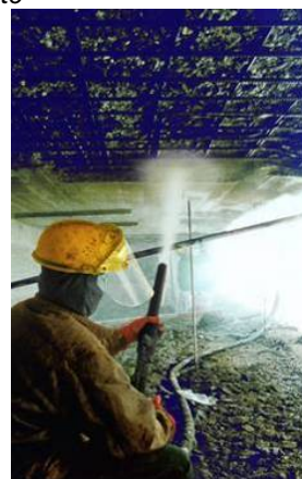
Preparación soporte: Chorro de arena
