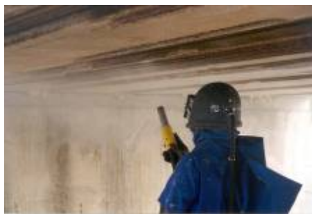
Preparación soporte: chorro de arena
