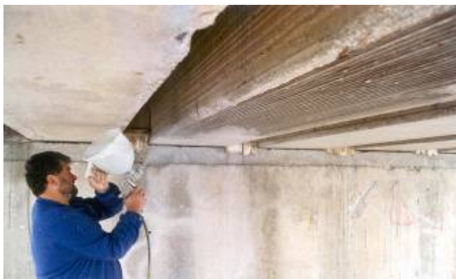
Aplicación capa de adherencia – Ejemplo SikaTop® Armatec-110 EpoCem®
