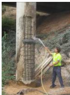
Hidratación del soporte a saturación
