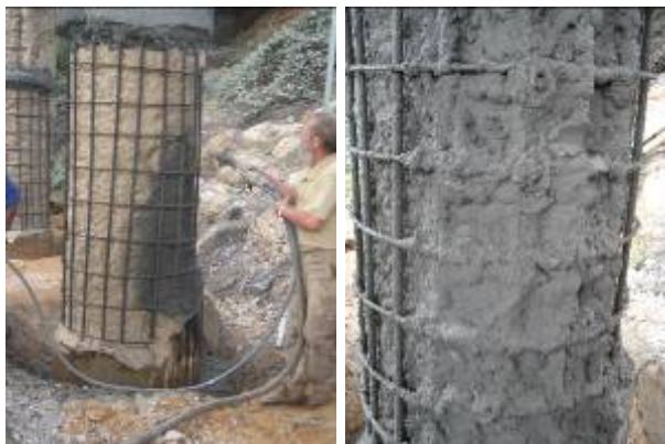
Aplicación de una fina capa y aplicación del espesor adecuado
