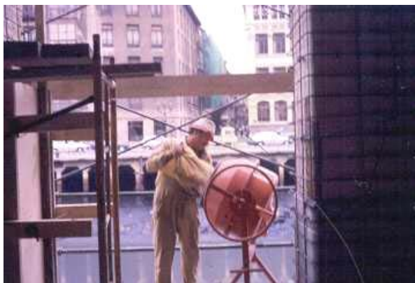
Aplicación mortero mediante la colocación de encofrado
