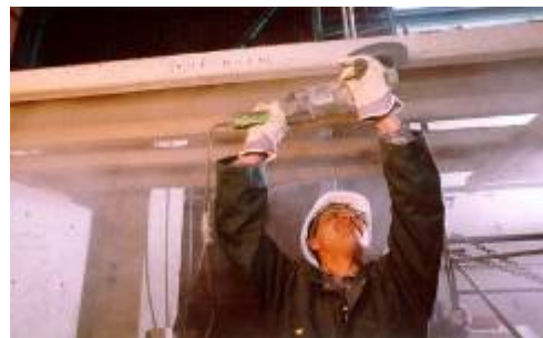
Preparación soporte: limpieza con radial
