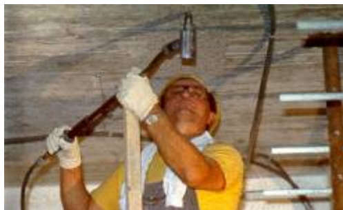
Preparación soporte: Abujardado mecánico
