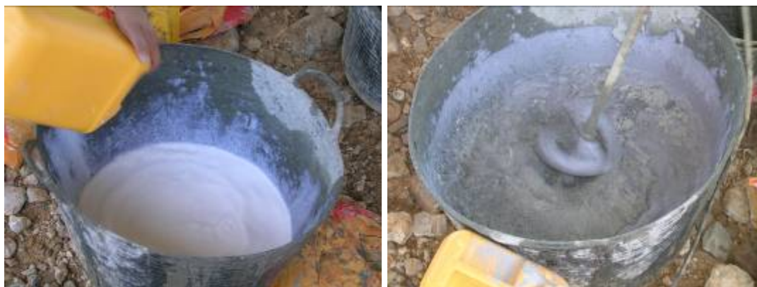
Mezclado productos predosificados – 2 componentes
