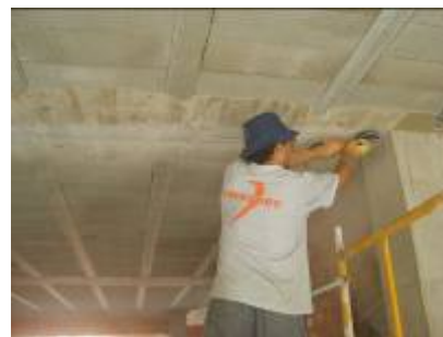
Preparación soporte: lijadora con disco de diamante
