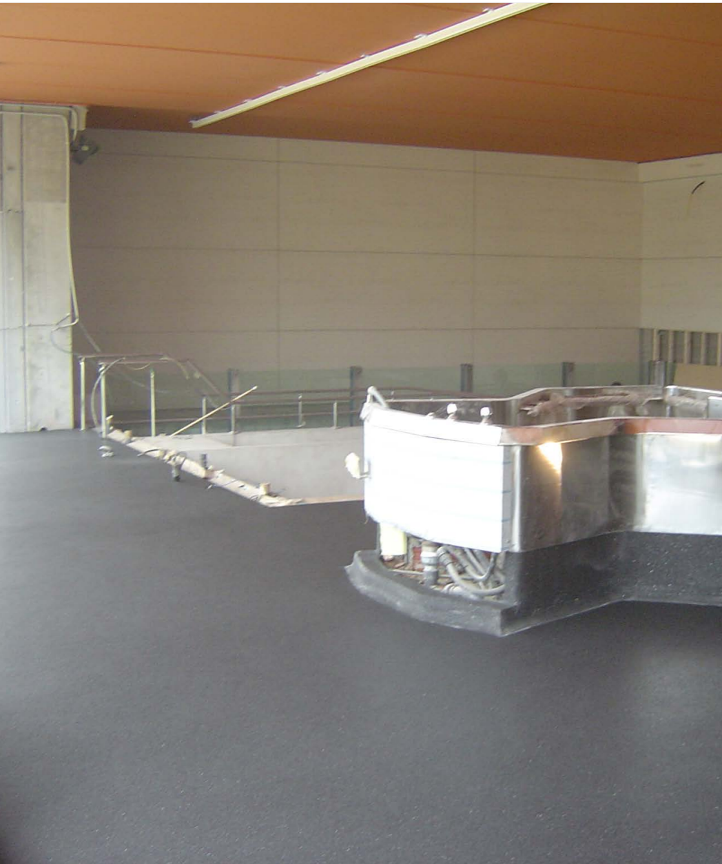
EDIFICIO DE FISIOTERAPIA ADJUNTO AL HOSPITAL DE SALT, GERONA Los pavimentos de la sala de talasoterapia y los baños se han impermeabilizado con SikaTop®-107 Seal y posteriormente se han recubierto con Sikafloor® , dándole un acabado de brillo-espejo.
