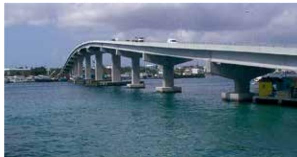
de casi 500 m de largo, dividido en 15 vanos. Construido en 1967, había sufrido un avanzado proceso de corrosión, por lo que en 2016 se procedió a su reparación, consistente en la aplicación de un pasivante de epoxi-cemento, Sika Top Armatec 110 EpoCem, regeneración con Sika Monotop 623 en el tablero y Sika Monotop 632 en las pilas, y protección de toda la estructura con el inhibidor de corrosión Sika FerroGard -903.
