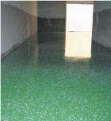
A continuación se puede aplicar encima cualquier sistema epoxi como en este caso el Sikafloor 261 decorado con chips de colores y un sellado final de Sikafloor 162, que dota al pavimento de una vistosa estética.
