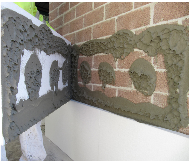
Figuras 3 y 4. Colocación del SATE
