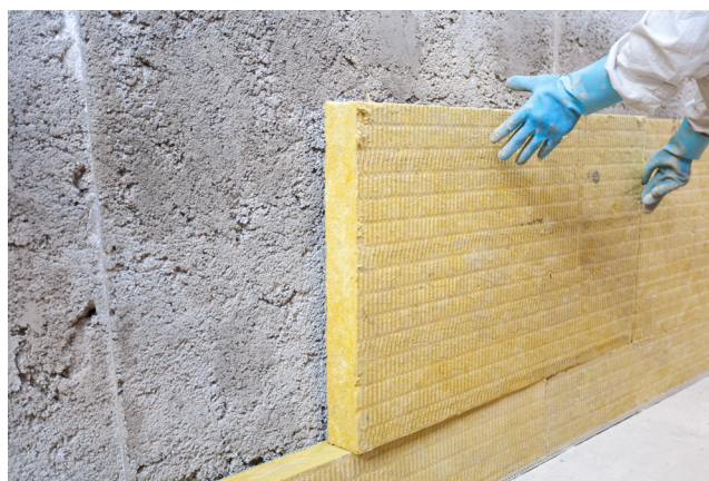
Figura 2. Colocación del SATE
