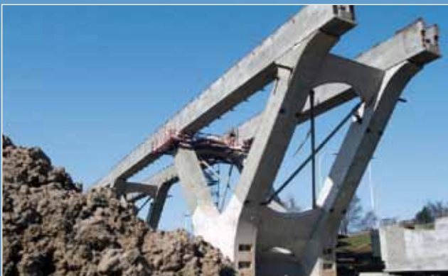
Viaducto entre Herve y Battice, Belgica
