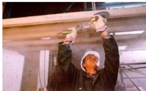
Fig. 4.2. Preparación soporte: limpieza con radial
