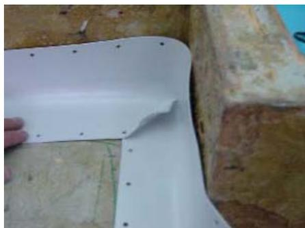
5. Presionar manualmente los lados de la arruga para que quede pegada totalmente ambos lados sin dejar ninguna zona sin soldar.
