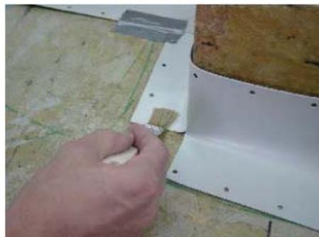
10. Aplicar Sika® Colma Limpiador en las áreas donde se va a colocar la pieza circular.
