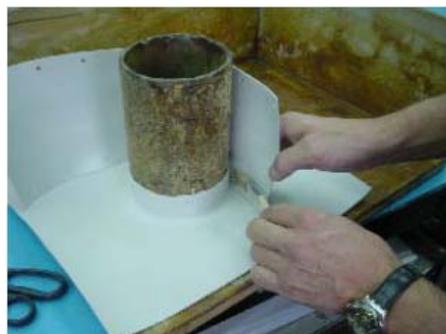
10. Aplicar Sika® Colma Limpiador tanto en la pieza cortada como en la colocada en la tubería.
