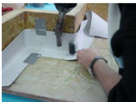
12. Soldar la pieza circular en un lado de la esquina presionando a la vez con el rodillo.
