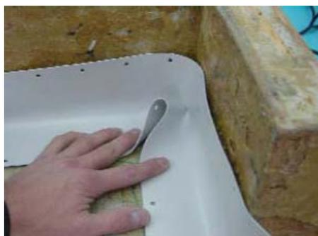
2. Colocar la banda centrada (la mitad en el plano horizontal y la otra en el vertical).
