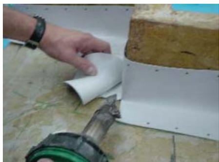
11. Soldar por puntos manualmente la pieza circular usando un soldador de aire caliente.
