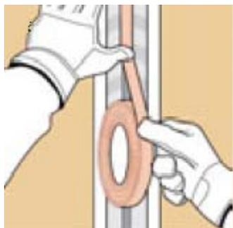
2. Usar una cinta adhesiva para tapar la junta, de manera que se evite la entrada de resina en ella.
