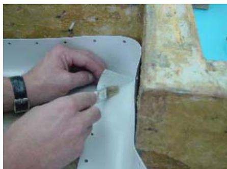
6. Aplicar Sika® Colma Limpiador en el lado de la arruga que se va a soldar (referido al plano horizontal) y sobre la zona de la Banda donde se soldará el pliegue (arruga).
