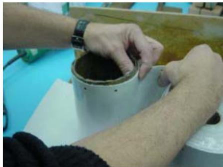
9. Cortar una pieza de Banda con un ancho de 15 cm para cubrir el perímetro de la tubería más un solape de unos 2-3 cm.
