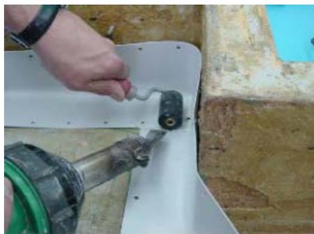
8. Usando el rodillo, presionar la Banda para que quede totalmente soldada.
