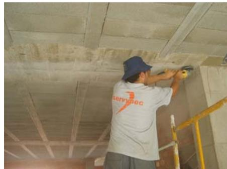
Fig. 4.4. Preparación soporte: lijadora con disco de diamante
