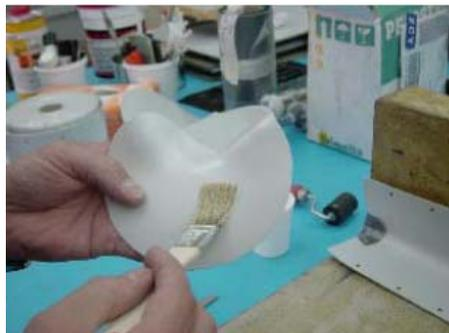
9. Aplicar con un pincel Sika® Colma Limpiador en la cara interna de la pieza circular.
