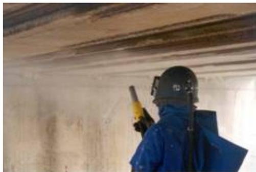
Fig. 4.3. Preparación soporte: chorro de arena
