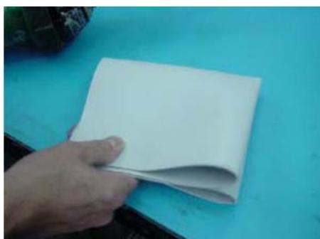
1. Cortar un trozo de Banda de unos 30 x 30 cm. Retirar el film de polietileno, y aplicar el Sika® Colma Limpiador a ambas caras de la Banda. Doblar la Banda dos veces.
