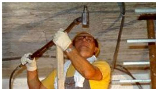
Fig. 4.1. Preparación soporte: Abujardado mecánico
