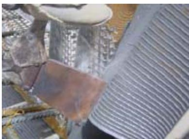
2. Soldadura del solape usando cuchilla eléctrica
