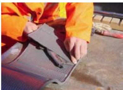
3. Colocar los extremos de las Cintas Sika® de PVC que van a ser soldadas una encima de otra. La superposición debe ser de 3 centímetros aproximadamente.
