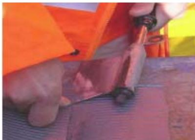
4. En la parte de atrás de los extremos de las Cintas Sika® de PVC, la soldadura debe realizarse como se describe en la figura 3.
