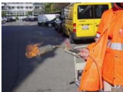
3. Calentar la cuchilla metálica con un quemador de gas.
