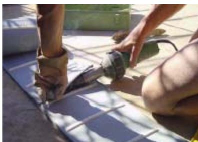
3. Colocar los extremos de las Cintas Sika® de PVC una encima de otra (la superposición debe ser igual a la anchura de la boquilla del soldador de aire caliente)
