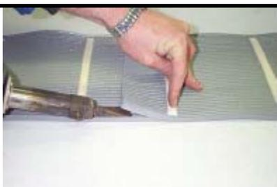
3. Soldadura del solape usando soldador de aire caliente
