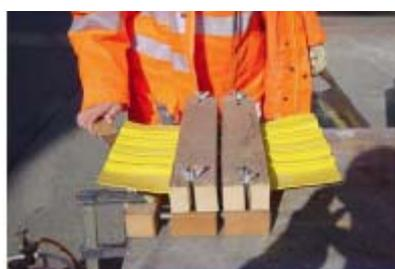
5. Presionar el sistema de abrazaderas enérgicamente durante 10 segundos aproximadamente.
