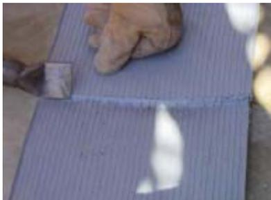
4. En la parte de atrás de los extremos de las Cintas Sika® de PVC, la soldadura debe realizarse como se describe en la figura 3.
