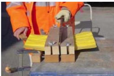
4. Colocar la cuchilla metálica caliente entre los extremos de las Cintas Sika® de PVC que van a ser soldadas y suavemente presionar el chasis hasta que los extremos de las Cintas Sika® de PVC estén tocando la cuchilla.
