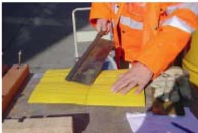
6. A través de toda la soldadura, debe verse un cordón de soldadura.
