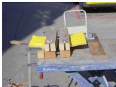
2. Sujetar con abrazaderas los extremos de las Cintas Sika® de PVC en el chasis apropiado.
