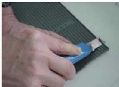
2. Quitar los nervios del interior de los extremos de las Cintas Sika® de PVC que van a ser soldados hasta la anchura de la boquilla del soldador de aire caliente (aproximadamente 3 cms).
