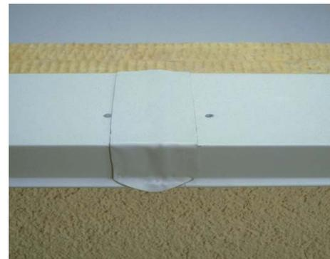
Cubra la junta del perfil colaminado con una banda de 10 cm de membrana no reforzada. Suelde la banda de membrana en ambos lados sobre el perfil colaminado Sikaplan®. La cinta adhesiva evitará el punzonamiento de los bordes de los perfiles sobre la impermeabilización.
