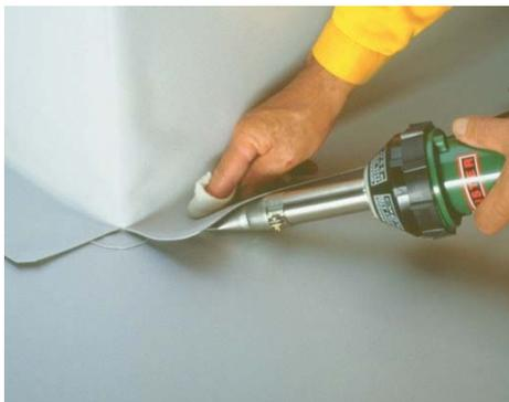
Cubra el peto con una tira de lámina y fíjela soldándola al borde de la impermeabilización principal. Recuerde: El ancho del solapado sobre la superficie de cubierta tiene que ser al menos de 12 cm para pasar por encima de la fijación mecánica (Ver capítulo Fijación perimetral de cubiertas con protección pesada).
