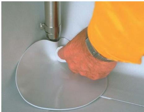
Primero suelde la pieza prefabricada en la esquina.
