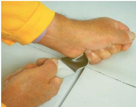
En caso de duda, por favor compruebe con una prueba manual de pelado (tirando fuertemente hacia los lados). Espere hasta que se haya enfriado.
