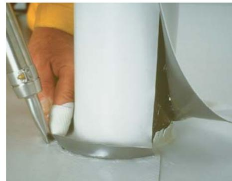
Sujete el soldador de mano en posición vertical para la última parte de la soldadura; esto evitará quemaduras.
