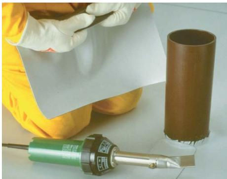
Caliente y estire la tira. Esto no es necesario si utiliza un tubo de conexión prefabricado Sikaplan®
