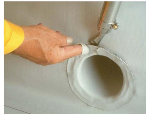
Coloque el tubo hecho con Sikaplan® y súeldelo a la membrana de impermeabilización de la cubierta.
