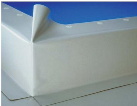
Cubra el peto con una tira de Sikaplan<sup>®</sup>. Fíjela a lo largo del peto sobre la membrana. Recuerde: El ancho del solape de la membrana ha de ser de al menos 12 cm para cubrir la fijación mecánica.
