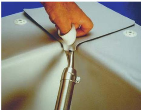
Suelva la parte prefabricada completamente sobre la esquina. Utilice una boquilla de 20 mm.
