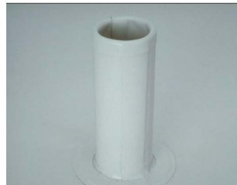
Tubería de ventilación con impermeabilización hecha in situ.
