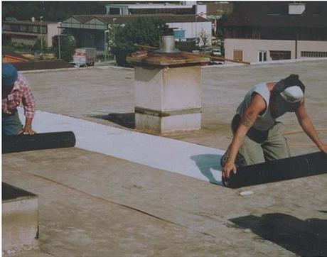
Enrolle las membranas corte las membranas en piezas de entre 15-25 m de largo y enróllelas. Las tiras cortas y los recortes también se pueden enrollar.
