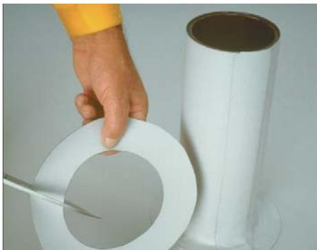
Si ve quemaduras, ampollas u otros fallos de soldado aplique un anillo corrector encima. Del mismo modo puede reforzar las soldaduras mal hechas, mediante parches. El diámetro interior de dicho anillo corrector tiene que ser 1.5 cm mayor que el diámetro exterior del tubo.
