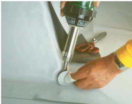
Suelde las piezas con la membrana de cubierta; separando los cortes de las esquinas. Suelde un parche redondo de membrana no reforzada a cada esquina (diámetro 5 cm).
