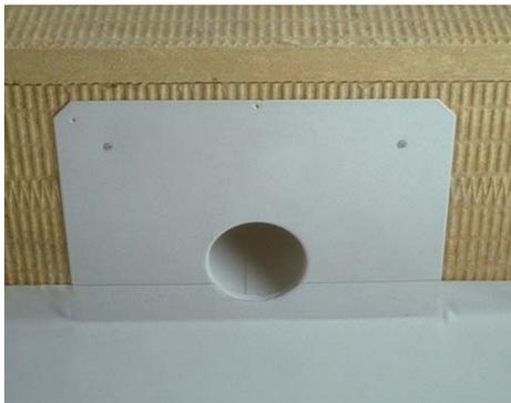
Coloque el aliviadero/desagüe y fíjelo con al menos cuatro tornillos. Por favor, fijese en que le borde horizontal se coloca bajo la membrana de cubierta. Limpie la superficie a soldar.
