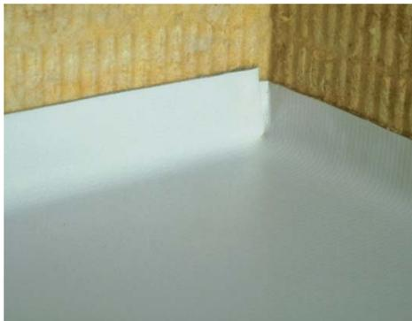
Durante la aplicación evite que el agua penetre entre las capas de la cubierta. Coloque la membrana sobre el peto 5 cm en posición vertical. Doble el rincón en posición vertical y suelde la parte plegada.
