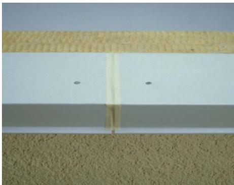
No suelde la lámina a ambos lados de la junta del perfil colaminado. Cubra la juntas con una cinta adhesiva.
