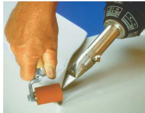
Suelva el pliegue sobre la membrana de cubierta.
