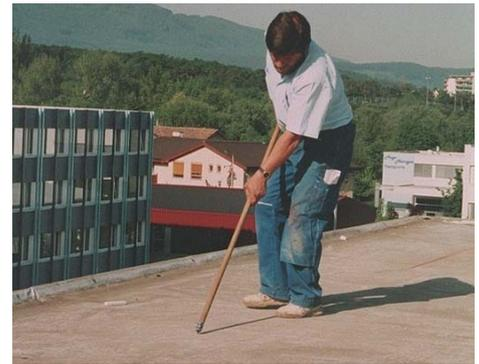
Corte la membrana de impermeabilización en tiras de 1 m de ancho, usando un cutter. Para mantener una posición de trabajo lo más vertical posible, fije la herramienta cortante a un palo.
