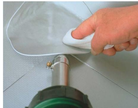
Suelde la superficie en contacto con la lámina horizontal.
