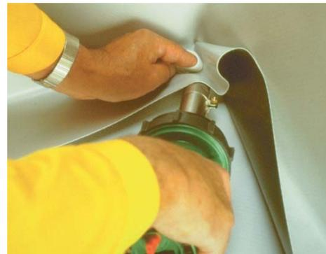
Fije el borde de la tira Sikaplan® sobre la membrana horizontal a todo lo largo del perímetro y sueldelo doblando correctamente la parte del rincón.
