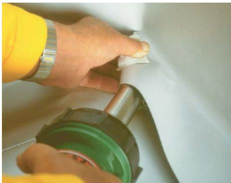
Suelde el pliegue de dentro hacia afuera.
