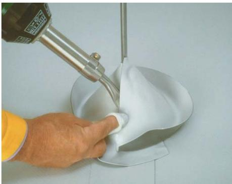
Suelde la pieza a la membrana de de la cubierta y sobre si misma en vertical. Utilice la boquilla de 20 mm.
