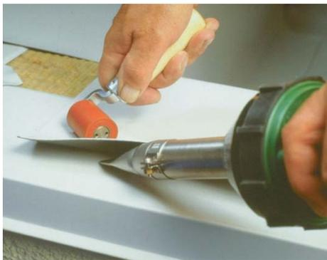
Como los perfiles metálicos transmiten mucho calor, el soldado se debe hacer en dos fases:
