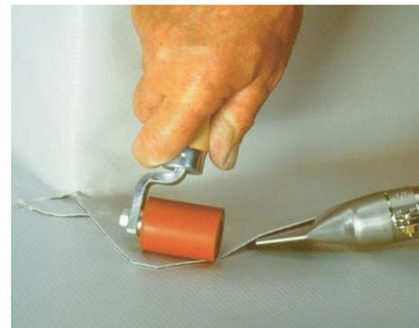
Suelde ambas partes solapadas por completo sobre la membrana de cubierta.
