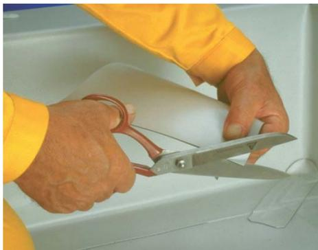
Corte una pieza rectangular de membrana no reforzada; debe ser tan ancha como el peto. Haga un corte en las esquinas a 45°.
