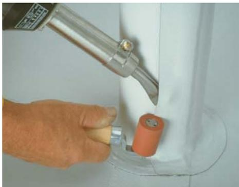
Suelva el solapado vertical de abajo hacia arriba. Utilice la boquilla de 20 mm.
