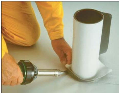
Suelde las partes de conexión estiradas sin adhesivo. Utilice la boquilla de 20 mm. Empezar con la superficie de conexión inferior de atrás hacia adelante. Protéjase los dedos con un trapo húmedo.
