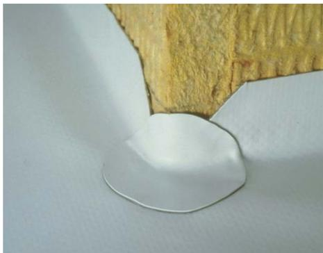
Durante el proceso de aplicación tiene que evitar que el agua penetre entre las capas de la cubierta. Suba hacia arriba la membrana a 5 cm y suelde la esquina con un parche ovalado.
