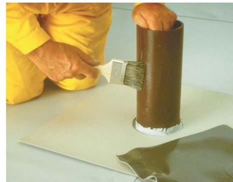
Aplique adhesivo al tubo y prepare la pieza para cubrir la tubería.
