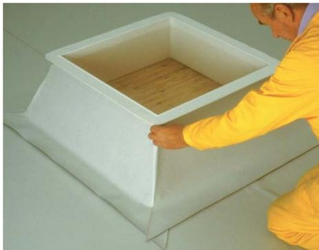
Adhiera la membrana vertical al soporte. Suelde la parte inferior sobre la membrana de cubierta.
