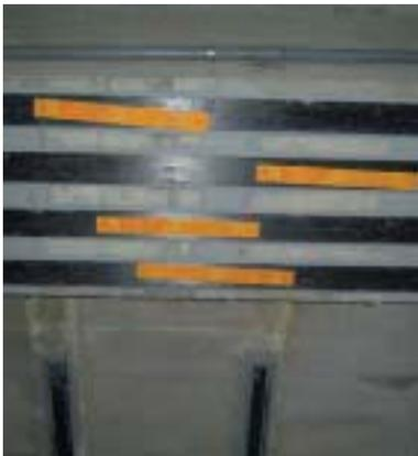
El corte del laminado en las longitudes deseadas se realiza en la propia obra y una vez limpiadas las superficies, se procede a la aplicación sobre el soporte de una película de la resina epoxi . En un primer momento se coloca el laminado sin ejercer presión hasta que se compruebe que está perfectamente situado en su sitio, para posteriormente presionar mediante un rodillo de goma dura que se irá pasando a lo largo de toda la longitud.
