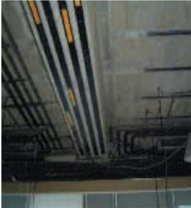
En un primer momento Ferlaval realiza la limpieza de superficies mediante medios mecánicos y manuales (radial con cepillo de púas y cepillado manual). Posteriormente se regularizan las zonas donde sea necesario mediante el relleno de agujeros y coqueas con los morteros epoxi, Sikadur 41 y Sikadur 31. Finalmente se coloca el sistema de refuerzo Sika Carbodur S 812, de 8 cm. ancho con el adhesivo de resina epoxi Sikadur 30. El espesor de la fibra es de 1,2 metro lineal.
