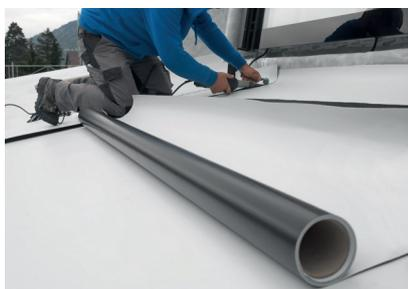
Altamente flexible como EPDM, incluso a bajas temperaturas, lo que permite un desenrollado más rápido de los rollos de membrana en la obra.
