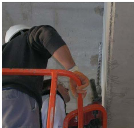
Fig. 5.9. Ejecución del agujero para el anclaje del angular
