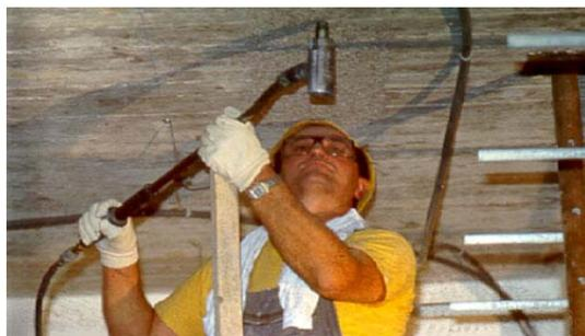
Fig. 5.2. Preparación soporte: Abujardado mecánico
