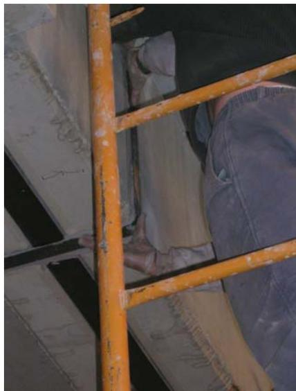
Fig. 7.10. Pegado del angular sobre el soporte
