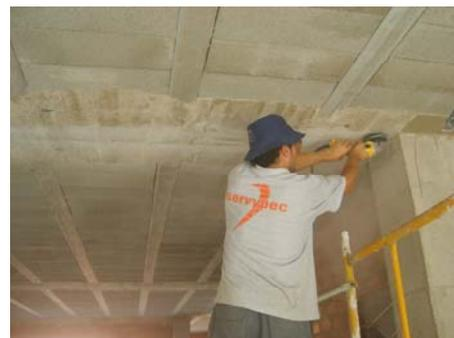
Fig. 5.5. Preparación soporte: lijadora con disco de diamante
