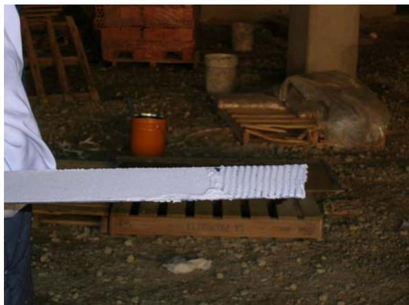
Fig. 7.4. Detalle de las acanaladuras del angular
