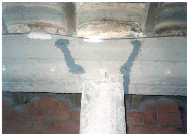
Fig. 5.1. Detalle de las fisuras inyectadas con resina
