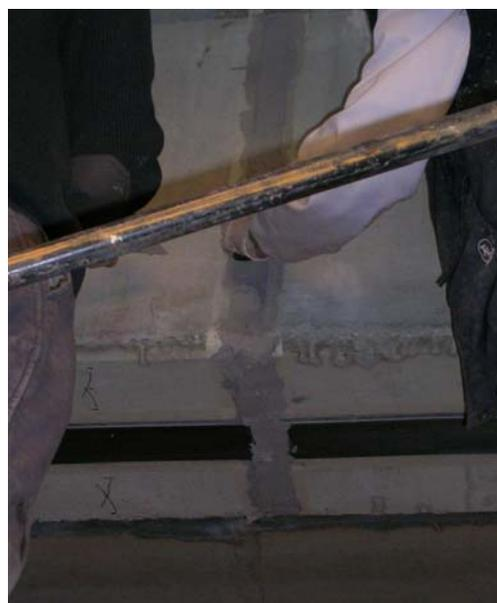
Fig. 7.5. Marcar la zona donde se va a colocar el      Fig. 7.6. Aplicación de la resina en el soporte angular
