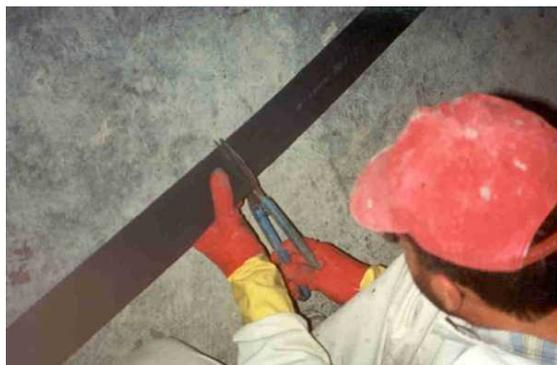
Fig. 3.3. Corte con tijeras especiales
