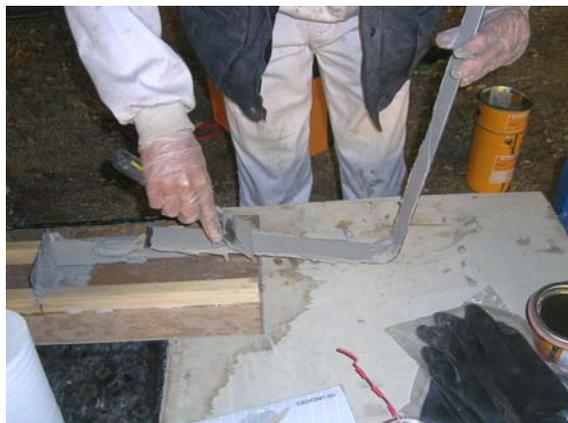
Fig. 7.7. Aplicación de la resina sobre el angular
