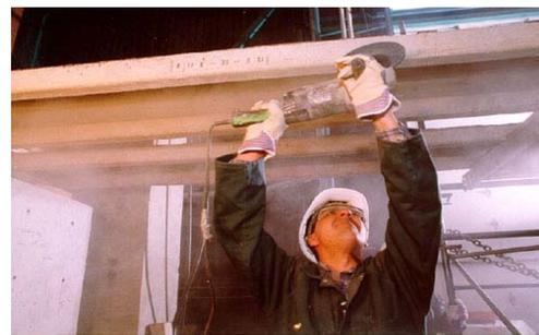
Fig. 5.3. Preparación soporte: limpieza con radial
