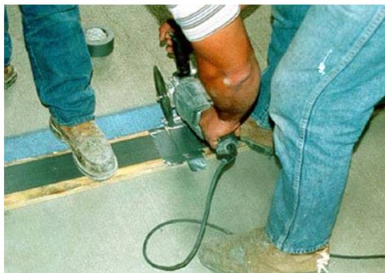
Fig. 3.1. Corte con radial
