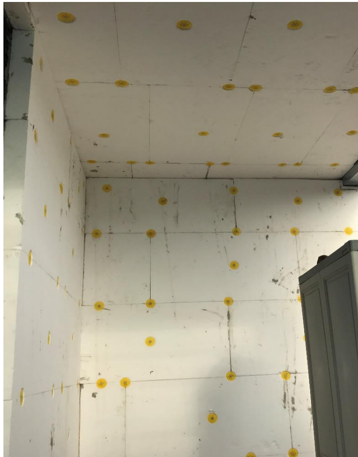
Instalación anclajes mecánicos: SikaThermocoat 8.
