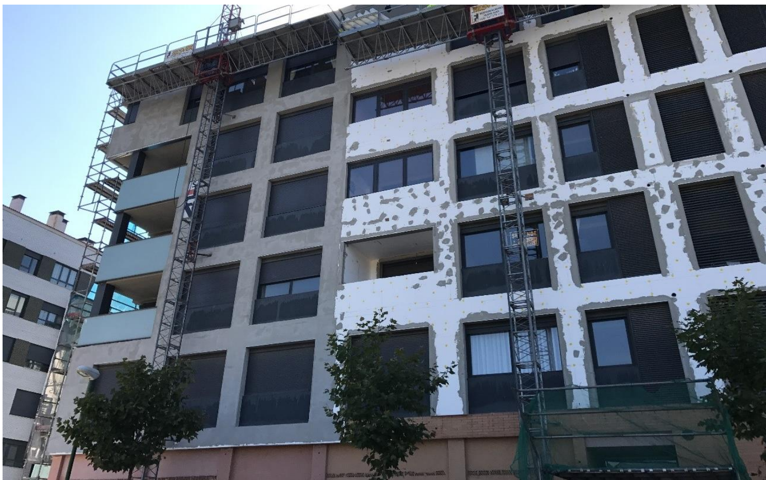
Fachada Principal: Aplicación del mortero de endurecimiento sobre placas de aislamiento térmico.
