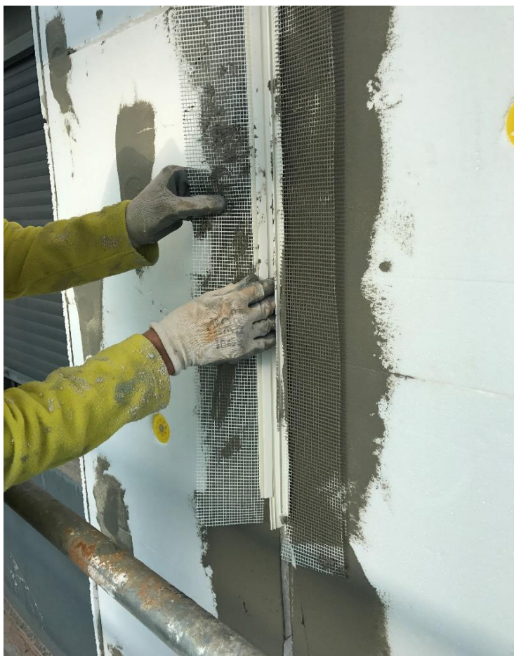
Instalación perfil junta de dilatación: SikaThermocoat 11
