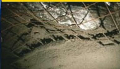
Hormigón proyectado. Huecos detrás de las armaduras/Rebote de proyección. **2**
