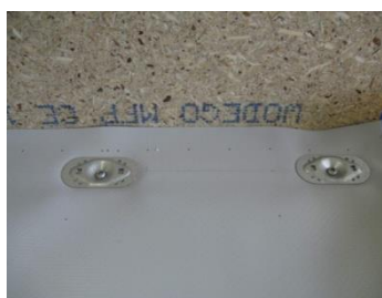
Fijación mecánica con arandelas metálicas
