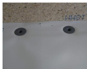
Fijación mecánica con tubos
