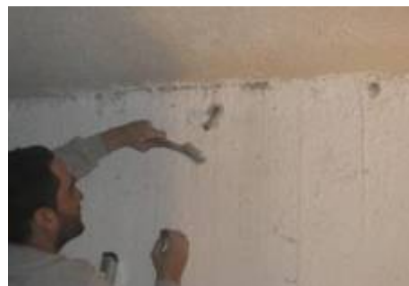
Figura 4.1-10 Colocación Inyector – introducción del inyector en el soporte
