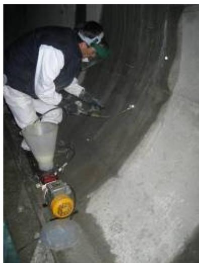
*Figura 4.1-15 Inyección fisura vertical*
