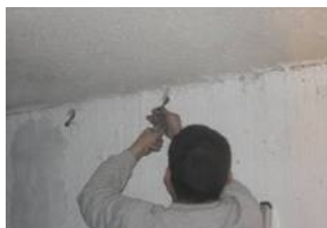
Figura 4.1-11 Ajuste del inyector
