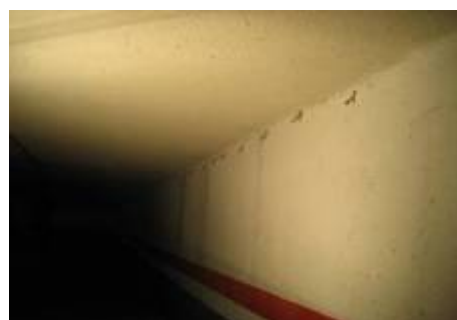
Figura 4.1-12 Inyectores colocados
