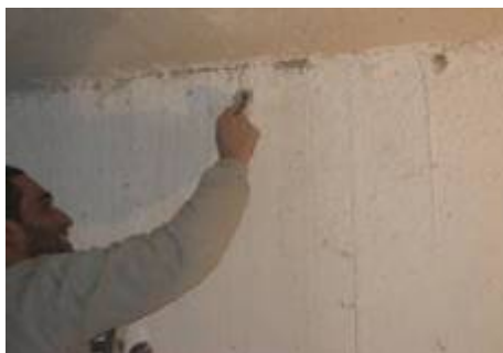
Figura 4.1-10 Colocación Inyector – introducción del inyector en el soporte
