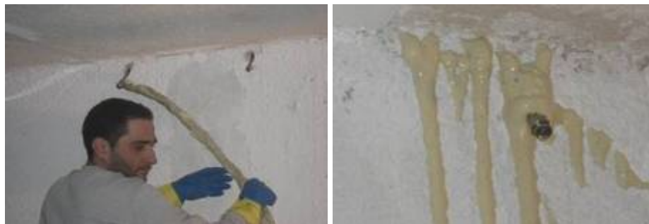
Figura 4.1-14 Inyección de la resina
