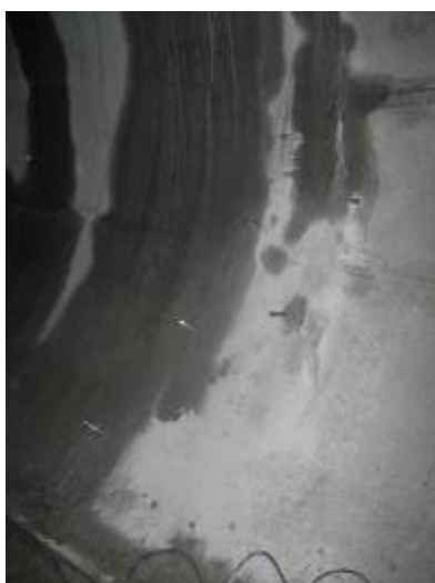
Figura 4.1-13 Colocación Inyector – fisura vertical
