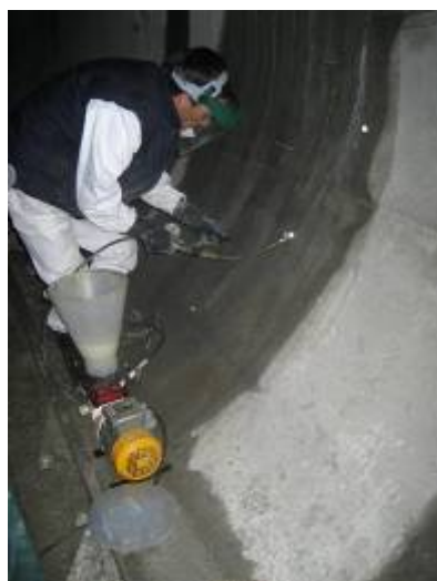
Figura 4.1-15 Inyección fisura vertical
