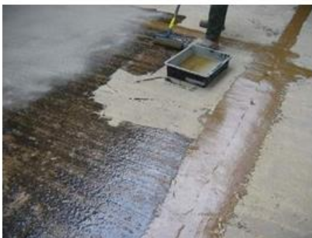
Imprimando con Sikafloor®-150 / -151
