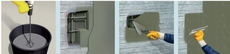
FORMULADO A BASE DE CEMENTO PORTLAND RESISTENTE A LOS SULFATOS, ÁRIDOS SILÍCEOS DE GRANULOMETRÍA SELECCIONADA, POLÍMEROS, FIBRAS Y ADITIVOS
