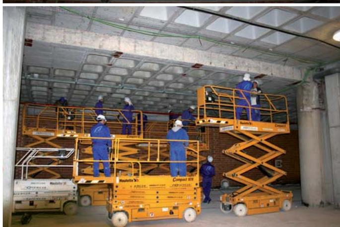
En un primer momento se realizó la limpieza de superficies mediante medios mecánicos y manuales (radial con cepillo de púas y cepillado manual), para a continuación reparar las posibles zonas dañadas y pasivar las armaduras mediante la aplicación del revestimiento de adherencia y protección, Sika® Monotop 610, en dos capas
