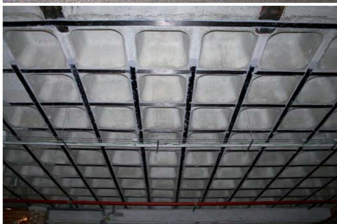
Esta tecnología a base de materiales reforzados con fibra de carbono consigue una gran estabilidad dimensional, presenta una enorme flexibilidad en la adaptación a la geometría de las superficies y está caracterizada por su poco aporte de peso a la estructura debido a la baja densidad del material.
