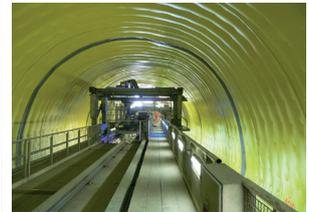
El Túnel de Base de San Gotardo en Suiza tiene 57 km. de largo y cuenta con 152 km de sistemas de galerías excavadas a través de la roca. Sus dos vías se conectan cada 325 m mediante conexiones, abriéndose camino a través de Los Alpes. Cada día pueden transitar por esta obra de ingeniería hasta 260 trenes de carga - con una velocidad máxima de 160 km por hora - y 65 trenes de pasajeros, que pueden alcanzar hasta los 250 km por hora.
