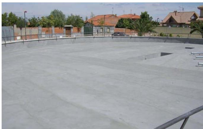
Por encargo del Ayuntamiento de Ciempozuelos, la empresa Opteimsa llevó a cabo el revestimiento de impermeabilización, en la solera y paramentos verticales del vaso de una fuente en esta localidad madrileña.
