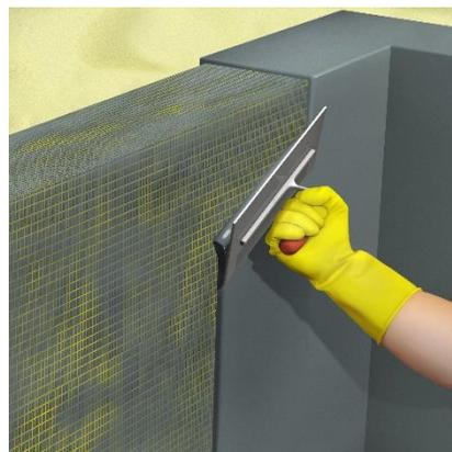
La armadura debe ser colocada cuidadosamente sobre la primera capa, evitando cualquier oclusión de aire por formación de pliegues o bolsas en la malla de fibra de vidrio. La unión entre mallas de fibra de vidrio se realizará por solape con una anchura comprendida entre 3 y 5 cm.
