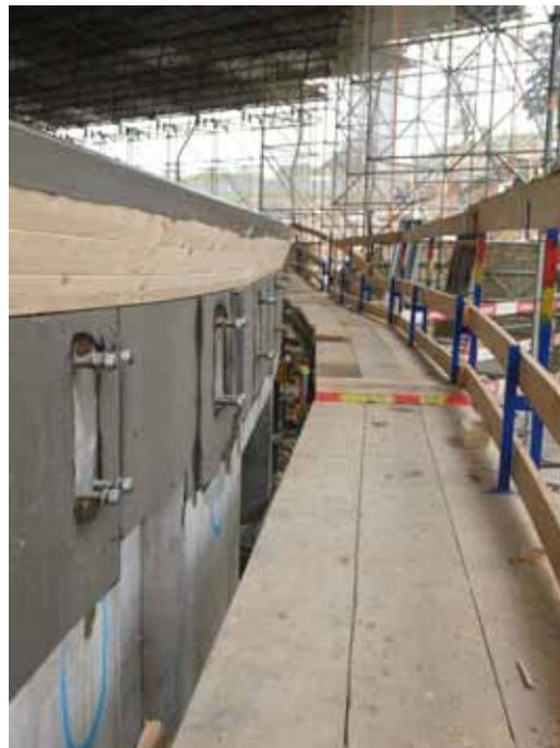
flujo óptimo de hormigón, la compactación y las resistencias finales. El comprobado agente reductor Sika® Control-60 se utilizó para reducir la contracción y aumentar así la durabilidad.
