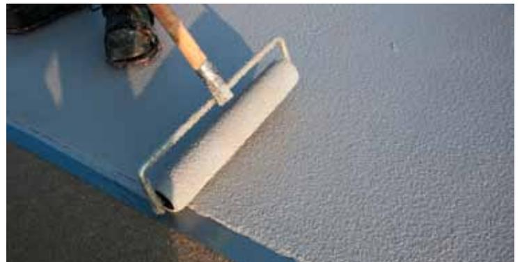
> Se incorporó Sika® Reemat Premium en el sistema Sikafloor®-32 Pronto para proteger las áreas de movimiento tales como juntas de construcción, grietas existentes y soportes. Este sistema con la inclusión de Sika® Reemat Premium ha sido completamente probado para cumplir con los más altos estándares de fisuras disponibles en el mercado. Esto incluye el Método B BSEN1062-7 que prueba el sistema completo a través de 20.000 ciclos
