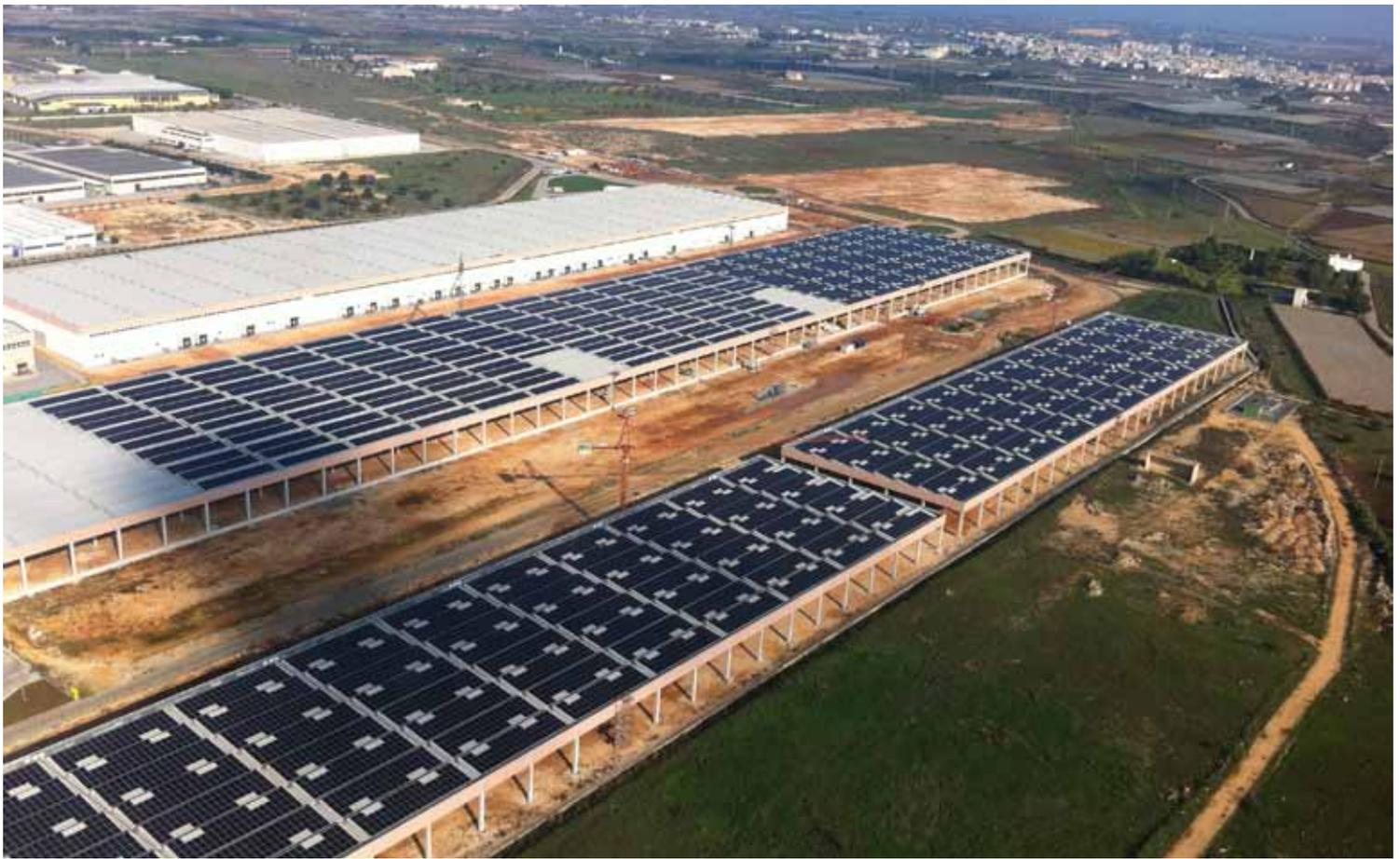
los módulos pueden ser directamente encajados o encajados a la subestructura preparada, sin la necesidad de consumir tiempo de atornillando o sujetando. Las soluciones existentes han demostrado que el tiempo de instalación puede reducirse hasta un 40%.
