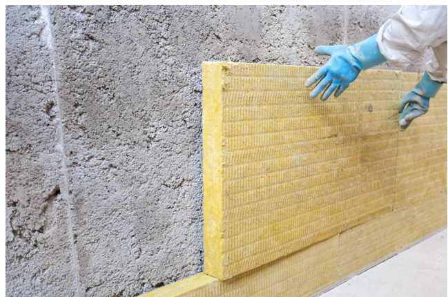
Figura 2. Colocación del SATE
