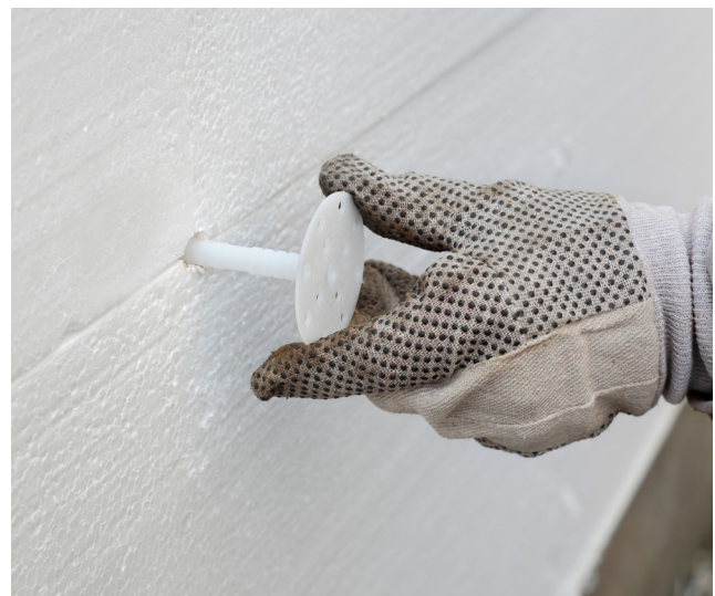
Figuras 3 y 4. Colocación del SATE
