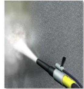
A baja presión hasta 18 MPa para la eliminación de suciedad, polvo, partículas sueltas, etc. A media presión de 18-60 MPa para la eliminación de la lechada superficial, contaminantes hidrosolubles, etc.
