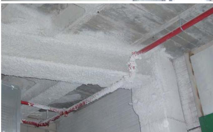
Opteimsa ejecutó el retacado de las vigas metálicas en techo y placas metálicas del Centro Comercial Parque Corredor de Torrejón de Ardoz (Madrid) mediante procesos de inyección, vertido o relleno —según la zona— con resinas epoxi.
