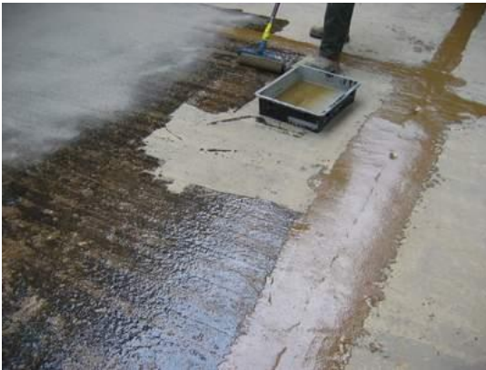
Imprimando con Sikafloor®-150
