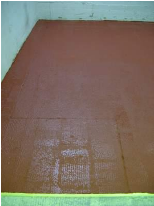
Espolvoreo a saturación después de eliminar el exceso de árido
