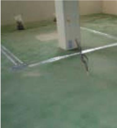
Una vez realizado el fresado de la superficie y aplicado el Sikaguard 720 Epocem en las juntas como barrera antihumedad, se extiende Sikafloor 156, imprimación de dos componentes, de altas prestaciones y baja viscosidad. Esta aplicación se realiza con rodillo de pelo corto y con un consumo medio sobre superficies niveladas de aproximadamente 0,300 Kg/m<sup>2</sup>.
