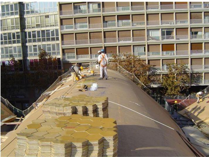
Sobre las ondulaciones que conforman las tablas de madera, se colocarán las piezas de trencadís de distintos colores
