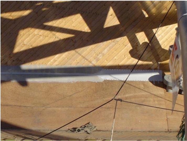
Las tablas de madera van colocadas a tope unas con otras, formando una superficie continua
