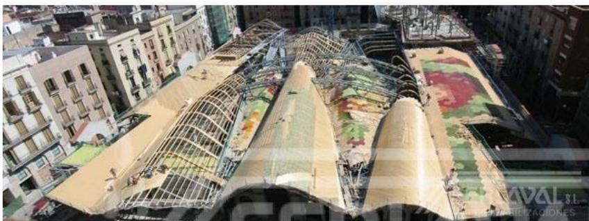
La forma de la cubiertas es ondulada en toda su superficie. El cerramiento está compuesto de tablas de madera superpuestas al esqueleto de vigas y cabios.
