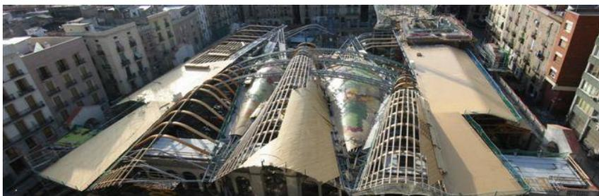
La estructura de la cubierta consistía en un armazón de vigas de madera de formas curvas. Un par de arcos metálicos le dan estabilidad al conjunto de la estructura
