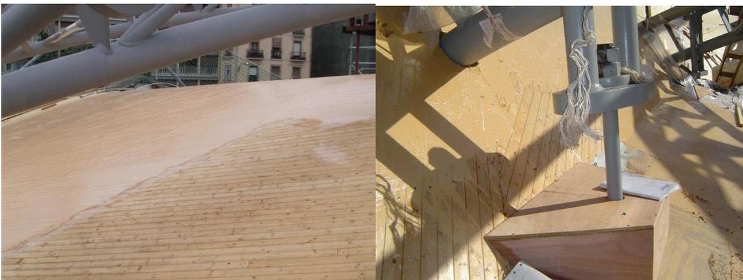
Sobre la superficie de tablas de madera se extiende el Sikabond-T8. Este producto es una masilla de poliuretano monocomponente. La función del SikaBond-T8 es impermeabilizar y proteger la cubierta, a la vez que sirve como adhesivo del trencadís
