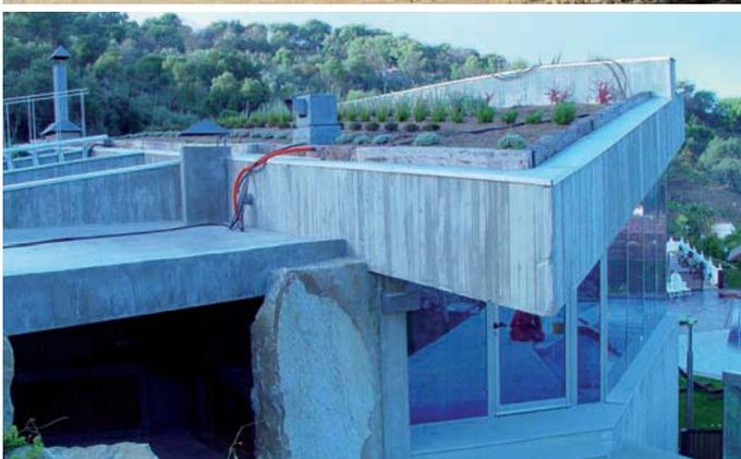
Cuando Verti&Calidad comienza con sus trabajos de impermeabilización de una cubierta ajardinada en Ubrique, Cádiz, se encuentran con una cubierta en bruto. Hubo que retirar todos los restos de la obra y eliminar los restos de hormigón y lechada que pudieran dañar la membrana
