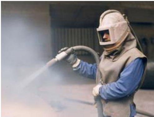
Preparación del soporte mediante chorro de arena
