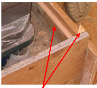
Lamas triangulares de madera que son instalados en el encofrado
