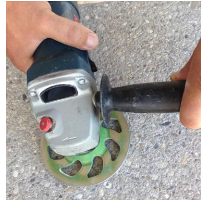
Soporte preparado con granallado
