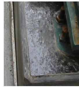
Después de desmontar el encofrado, todas las bridas están biseladas
