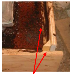
Durante la colocación
