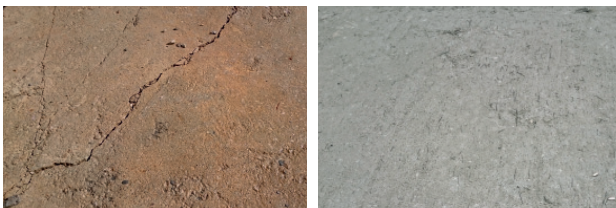
(a) Aspecto visual de las soleras después de tres años de servicio: (a) solera reforzada con mallazo de acero; (b) solera reforzada con fibras Sikafiber T 48
