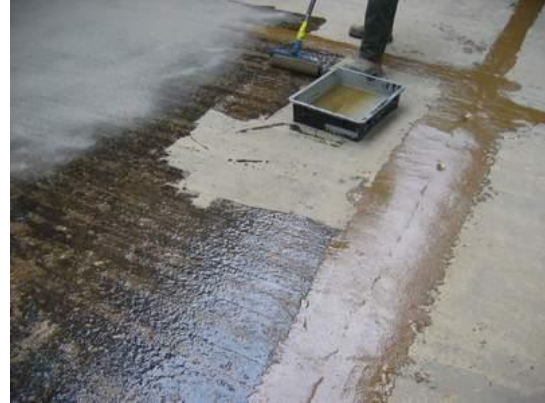
Imprimando con Sikafloor®- 151
