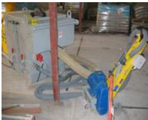
Escarificadora con aspiradora
