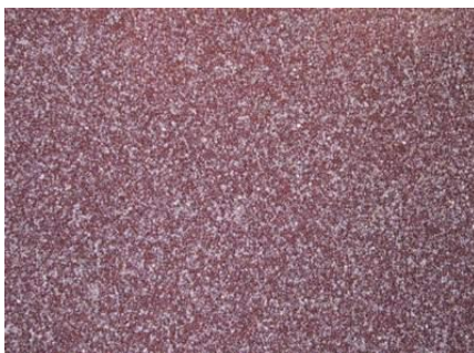
Espolvoreo a saturación después de eliminar el exceso de árido
