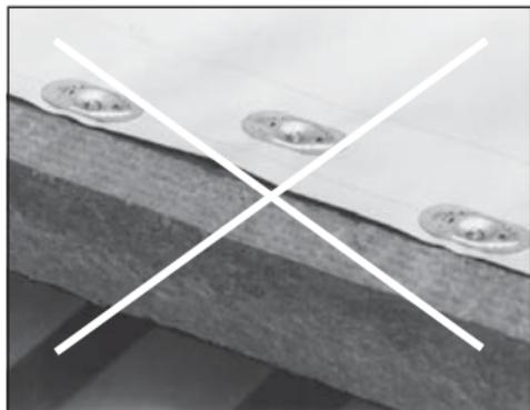
Las sujeciones y arandelas dentadas Sarnafast se deben instalar con la herramienta de ajuste automático Sarnafast o mediante un destornillador eléctrico con indicador de profundidad.
