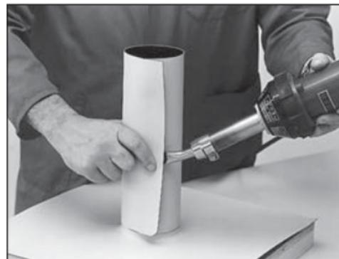
Cortar el recubrimiento de la tubería de manera que se solape 30 mm para la soldadura de la junta.
