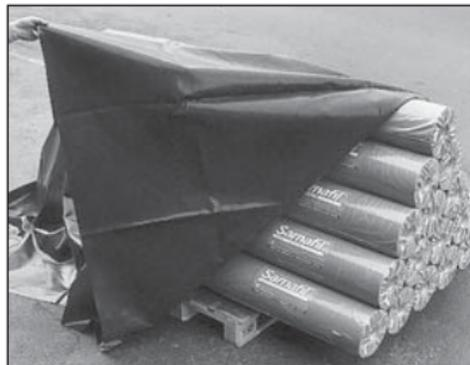
En la obra, los rollos de lámina Sarnafil® TG/TS tienen que estar protegidos de la intemperie. Si se almacenan en lugar seco, se puede reducir al mínimo el trabajo que supone la preparación de las uniones.
