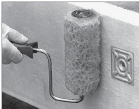
El adhesivo que se aplique sobre el material de soporte 10 horas antes de instalar la lámina precisa de una capa de adhesivo adicional.
