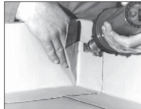
Soldar la bolsa cerrada al saliente para formar un cierre estanco completo (soldadura previa y soldadura final), comenzando por la zona de la esquina vertical, y soldando la zona de solape vertical.
