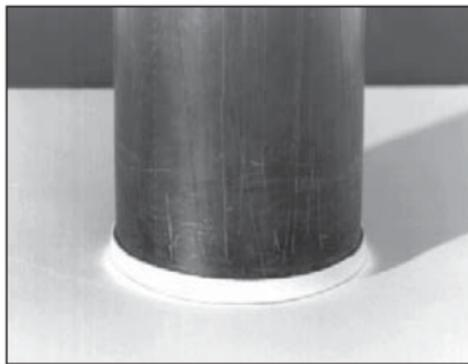
Deslizar la lámina, sin calentarla, en la tubería que entra para crear un cerco de seguridad elevado y soldar a la base de la membrana.
