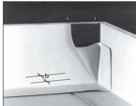
Cortar y pegar la segunda tira en la zona ascendente de manera que el solape  $b$  mida lo mismo tanto en la superficie de la cubierta como en la esquina. De esta manera, se forma un pliegue en ascensión.
