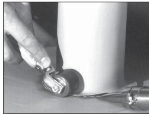
... y a continuación realizar la soldadura final utilizando un rodillo de presión Sarnafil®.
