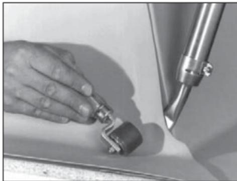
... y luego realizar la soldadura final, teniendo cuidado de sostener el equipo correctamente.
