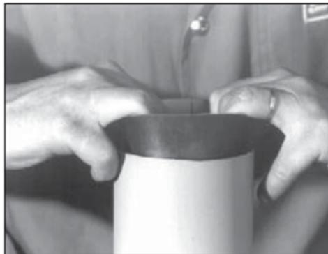
Introducir la lámina así moldeada en la tubería de ventilación de manera que sobresalga aprox. 30 mm. Doblar la sección moldeada sobre la tubería de ventilación ...
