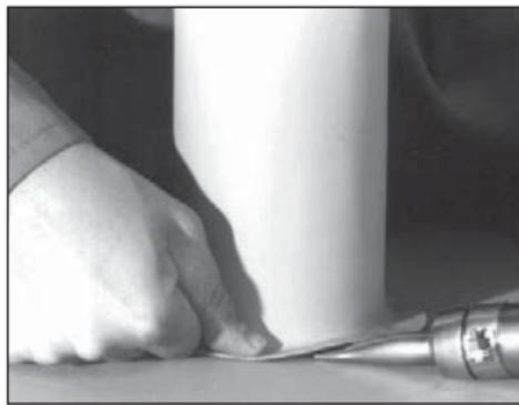
Soldar previamente el recubrimiento de la tubería a la lámina de conexión a la vez que se presiona con un dedo ...
