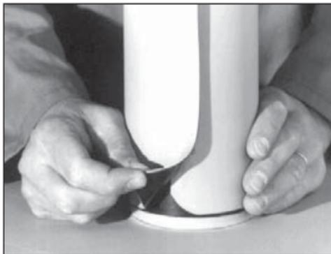
Recortar alrededor del solape superior e inferior de la lámina.
