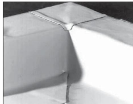
Soldar con habilidad la esquinera y redondear la esquina exterior del borde de la lámina.
