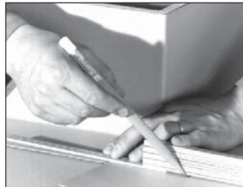
Cortar la esquinera de manera que coincida con el solape inferior de la tira Sarnafil®. Redondear la esquina que sobresale.
