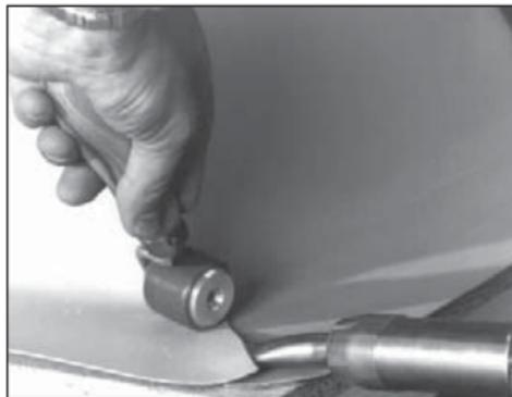
Realizar la soldadura previa y la soldadura final de la junta horizontal.
