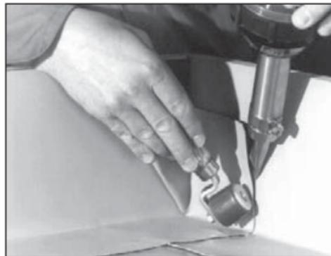
Soldar la tira tapajuntas por la superficie de solape a la primera tira de Sarnafil® y a la membrana de la superficie de la cubierta.
