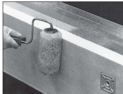
El adhesivo Sarnacol T 660 se aplica uniformemente con un cepillo o un rodillo. Los materiales absorbentes precisan de dos capas de adhesivo.
