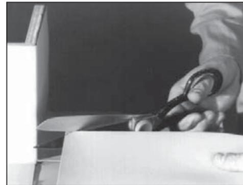
Cortar la esquinera de aprox. 50 mm de largo. A continuación, redondear la esquina que se tiene que colocar en el borde vertical.
