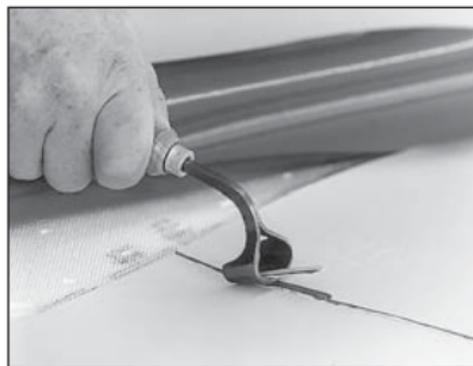
Todas las uniones transversales de cualquier grosor de membrana se tienen que biselar para la soldadura manual y automática.
