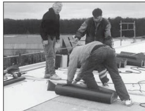
Se puede colocar una membrana de 1.00 m de ancho Sarnafil® TS a lo largo del perímetro y en las zonas de las esquinas. El solape y la soldadura se realizan como se ha descrito anteriormente.
