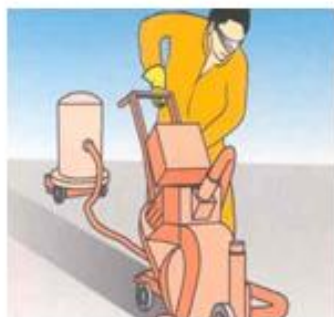
Preparación del soporte: Granallado u otro medio mecánico. P.e. Blastrac
