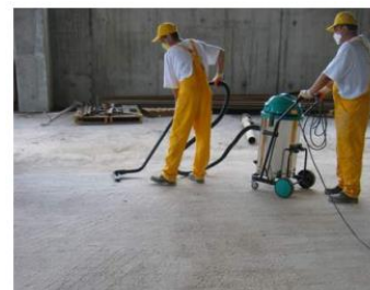
Limpieza de la superficie
