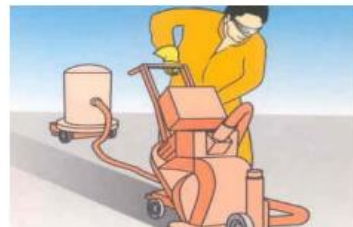
Preparación del soporte: Limpieza a presión u otro medio mecánico P E. Blastrac.
