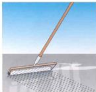
Eliminación del aire ocluido Pasar inmediatamente el rodillo de púas. P. e. rodillo Polyplan.
