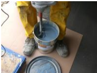
Mezclado del Sikafloor®-305 W
