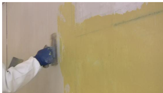
Aplicación sobre cartón yeso imprimado con Sika Top 50
