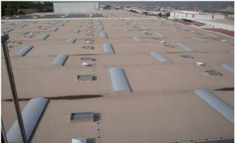
Moncas hubo de ejecutar la reparación completa de la nave principal de SEAT Cros y anexos, con la creación de una cubierta tipo deck con impermeabilización de poliolefinas flexibles, y mejora del aislamiento y de la iluminación cenital.
