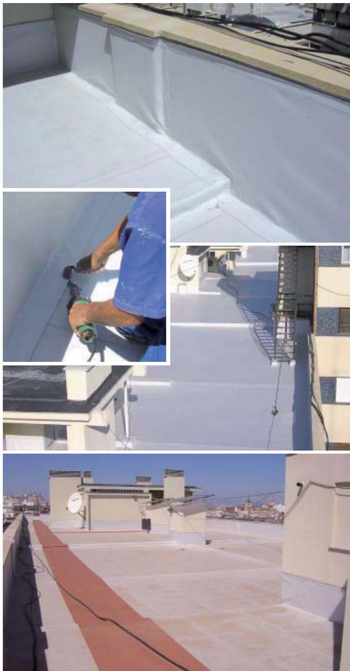
Opteimsa realizó la impermeabilización general de la cubierta de un edificio situado en la calle Raimundo Fernández Villaverde de Madrid, mediante el sistema de lámina de PVC Sika Trocal.
