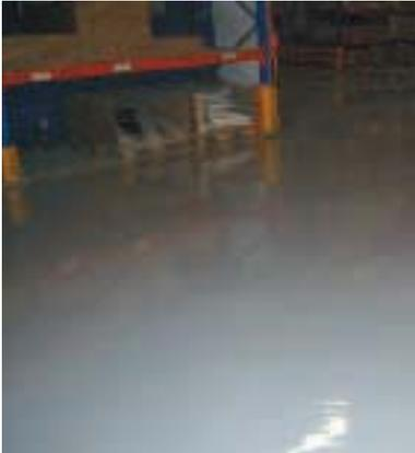
Los pavimentos industriales se caracterizan por una serie de requisitos fundamentales. Deben presentar alta resistencia a la abrasión, impermeabilidad al agua y permeabilidad al vapor de agua, resistencia a los productos químicos, buenas condiciones higiénicas y sanitarias, gran resistencia a los golpes y ser antipolvo, y por lo tanto de fácil limpieza y mantenimiento.
