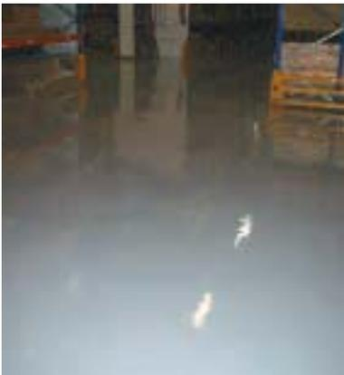
Para realizar este sistema Aplicaciones Químicas Insulares aplicó en primer lugar Sikafloor 156, imprimación a base de resinas epoxi, para seguidamente colocar el Sikafloor 261, ligante a base de resinas epoxi, coloreado y de baja viscosidad que, mezclado con la arena de granulometría especial Sikadur 501, constituye este mortero epoxi autonivelante.
