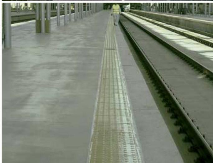
Probasur tuvo que llevar a cabo trabajos de acondicionamiento en las plataformas de la Estación del AVE en Málaga. Se emplearon para ello sistemas de pavimentos epoxi, la solución más adecuada para estos casos gracias a su estética, resistencia a la abrasión, facilidad de limpieza y mantenimiento.
