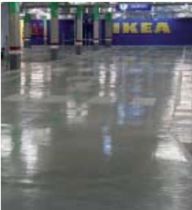
Finalmente se aplica una última capa de sellado mediante Colmasol – E , pintura de protección y decorativa a base de resinas epoxi, empleada fundamentalmente en pavimentos de garajes y en suelos de naves industriales, talleres, cadenas de montaje, o pasillos, sometidos a solicitudes medias-bajas.
