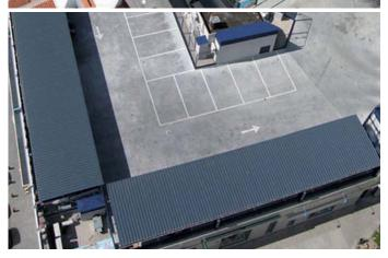
La obra consiste en la ejecución de una cubierta de un edificio industrial utilizada como aparcamiento. La cubierta protege a la parte de centro comercial y las tiendas existentes El acabado elegido, por este motivo, es de hormigón pulido.
